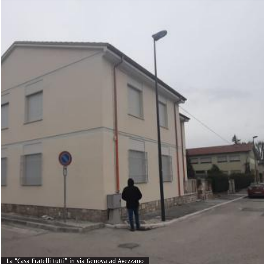
La «Casa Fratelli tutti» in via Genova ad Avezzano
